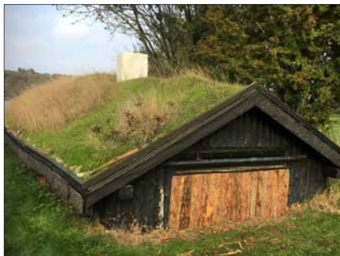
Udskiftning af beklædningen er igang
