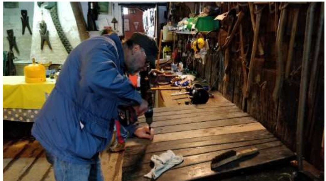
Der arbejdes på dørken
