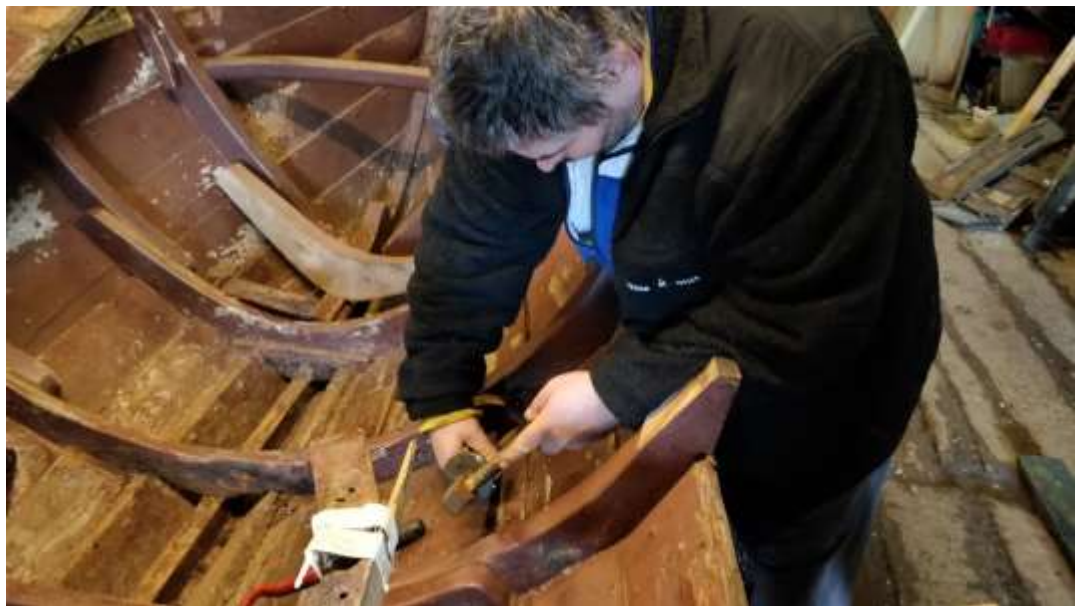
Der arbejdes på at tage bundstokken ud
