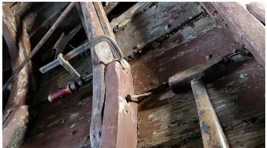
Stabilisering af bundstokke, da boltten der samler dem skal bankes ud
