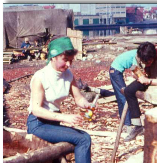
Træarbejdet - vikingskibet bygges i slutningen af tresserne.
